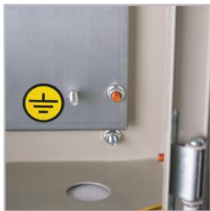
Шпилька заземления на монтажной панели.
